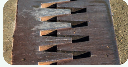
Köprünün bağlantı noktaları arasında boşluk bırakılması
