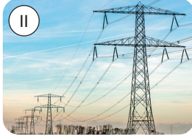
Yaz aylarında elektrik tellerinin sarkması
